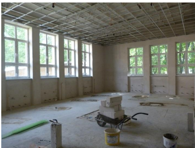
Renovácia južného traktu
