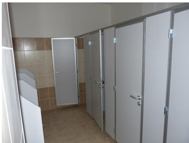
Upravené žiacke sociálne zariadenie
