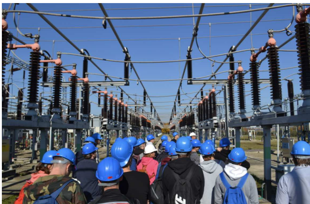
Obr.: Pole rozvádzačov 220 kV siete
